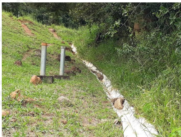
CANALETA PARCIALMETE OBSTRUIDA NA OMBREIRA ESQUERDA.
