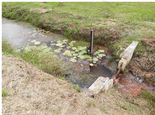
VEGETAÇÃO ALTA DENTRO DO DRENO DE FUNDO.
