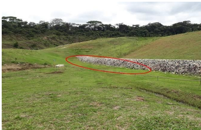
SURGÊNCIA INDENTIFICADA NO ULTIMO TALUDE DA BARRAGEM.
