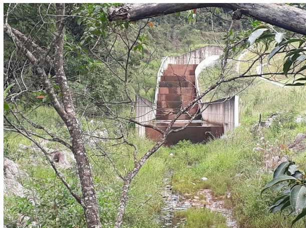
SAÍDA DO CANAL EXTRAVASOR COM PRESENÇA DE VEGETAÇÃO ALTA.
