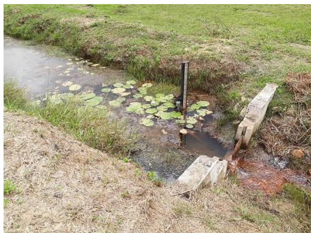
VEGETAÇÃO ALTA DENTRO DO DRENO DE FUNDO.
